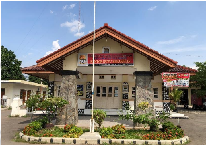
Gambar 3.1. Kantor Desa Kebarepan Kecamatan Plumbon Kabupaten Cirebon
