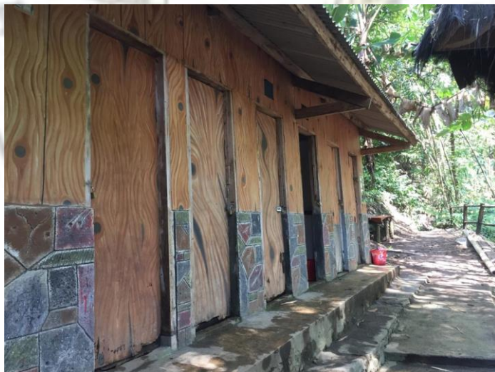
Gambar 3.11 Ruang Ganti Dan Bilas Objek Wisata Cikadongdong River Tubing
